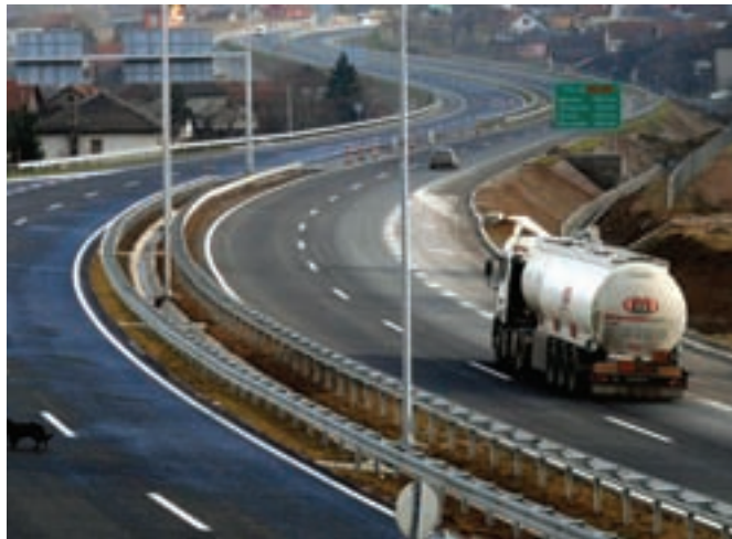
Novoizgrađena dionica autoceste
