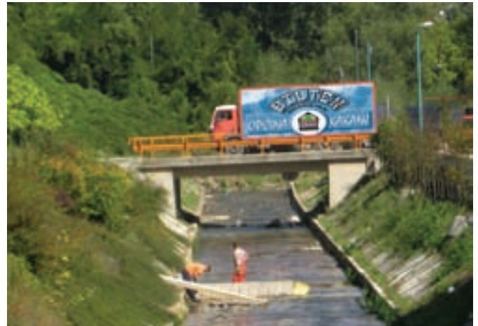
Radove izvodi Trgošped
